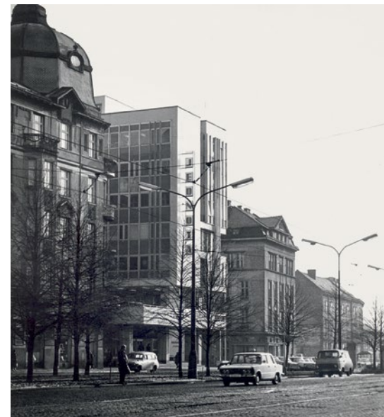
↓ Vladimír Polesný – Ivo Kučírek – Alois Haltmar, Administrativní budova Svazu spotřebních družstev (Jednota) Olomouc, 1966–1974, dobová fotografie, MUO
